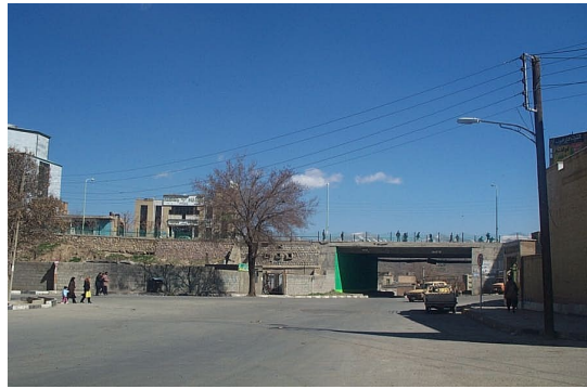
پل خیابان فردوسی سنندج
